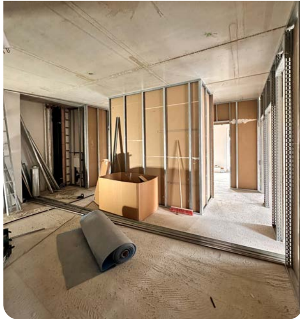
Eindruck von der Baustelle
